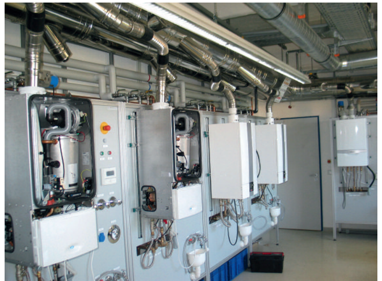
Bilder 4+ 5 • In der Praxiswerkstatt mit fest installierten und voll funktionsfähigen Wandheizkesseln aller führenden Hersteller wurde die Praxistauglichkeit der verschiedenen Versionen des Dirtmag Slim getestet.
