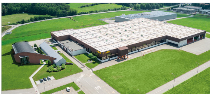
Caleffi 3 - Montages automatiques et injection plastique Gattico - ITALIE
