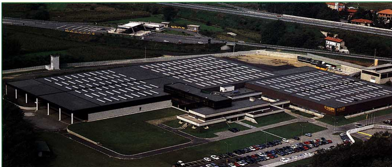
Veduta aerea della sede CALEFFI in Fontaneto d'Agogna (NO)
