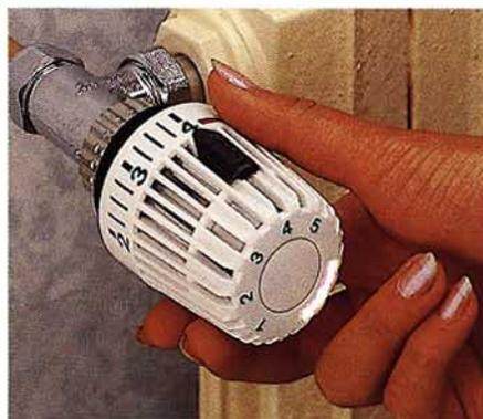
Nell'operazione di accoppiamento testina-valvola, l'indicatore del valore di taratura va posizionato nella parte superiore del comando termostatico, per consentire una comoda lettura della regolazione.
