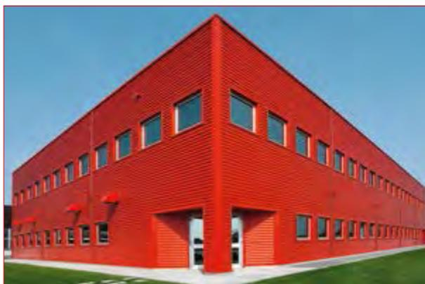
A necessidade energética do edifício (15,86 kWh/m<sup>2</sup> ano) recai na classe A. Este resultado foi obtido adotando uma forma arquitetónica muito compacta, elevados coeficientes de resistência térmica para as superfícies de dispersão (quer opacas quer transparentes) do revestimento, e recorrendo ao uso de energias alternativas.
