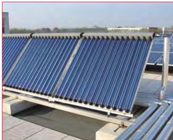
Ambos os tipos de painéis são servidos (ver esquema das págs. 22 e 23) por circuitos independentes entre si e acumulam energia térmica em reservatórios distintos. É, assim, possível estudar as diversas condições de trabalho (e, particularmente, as possíveis temperaturas máximas de funcionamento) dos 2 tipos de painel atualmente mais difundidos.
