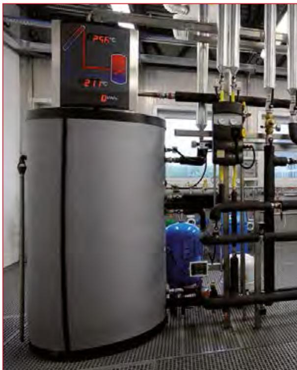
As instalações térmicas e hidrossanitárias foram realizadas quer para climatizar os ambientes de trabalho, quer para fornecer ao laboratório os fluidos de teste numa ampla gama de caudais, pressões e temperaturas.
