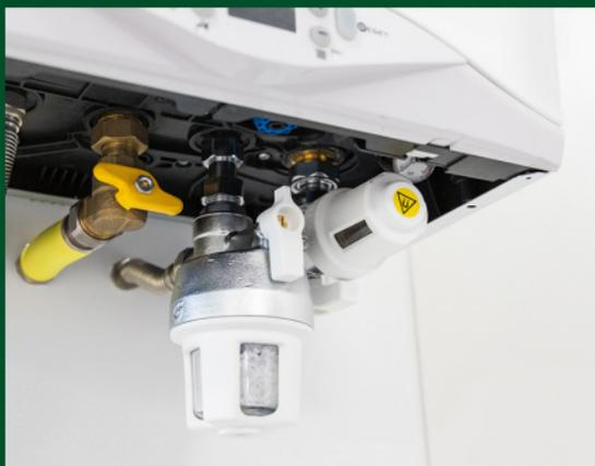
Per una protezione completa degli impianti domestici è possibile abbinare sotto la caldaia il **filtro defangatore Caleffi XS®** sul ritorno dell'impianto di riscaldamento.
