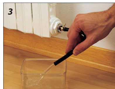
3 Ištraukite vandens išleidimo žarną, jos galą nukreipkite į vandens talpyklą
