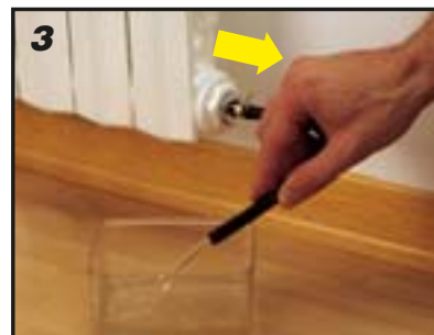
3 Extrair o tubo, orientando-o para uma bacia.
