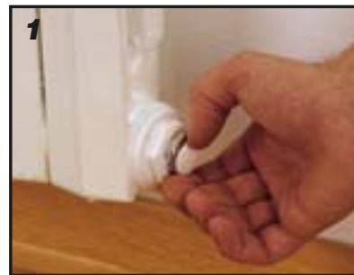
1 Retirar a tampa de protecção.
