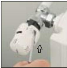
**1.** Rodar o manípulo para a posição de toda aberta (Pos.5). Com a ajuda de uma chave de parafusos soltar o anel branco da extremidade inferior da cabeça na direcção do corpo da válvula até ao fim.
