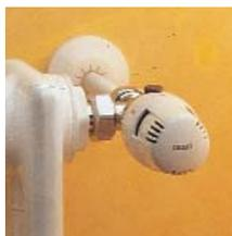
A utilização do comando 200 é indicado em todos os casos em que a colocação do radiador não influencie o sensor incorporado na válvula na leitura da temperatura ambiente.
