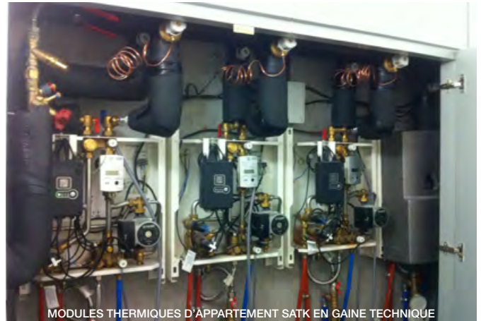
MODULES THERMIQUES D'APPARTEMENT SATK EN GAINE TECHNIQUE
