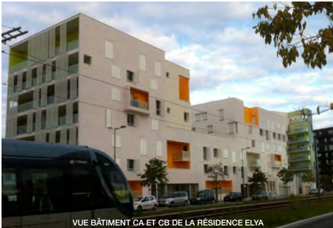
VUE BÂTIMENT CA ET CB DE LA RÉSIDENCE ELYA
